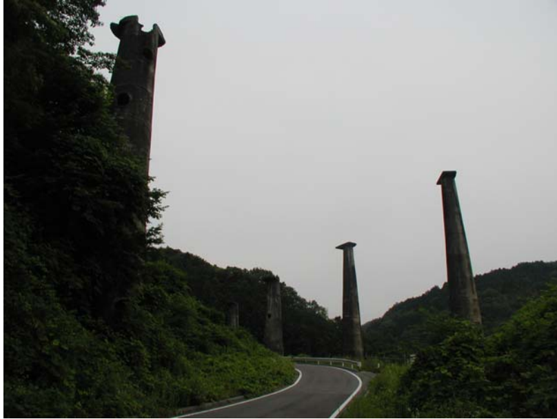
・骨材を選別し、貯蔵していた骨材プラントの塔
