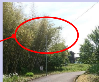
対象地の状況② (竹が電線に接触)
