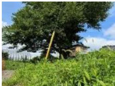
空き地の大木が隣家に近接
