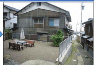
【解体後】跡地（約150㎡）に ポケットパークを整備
