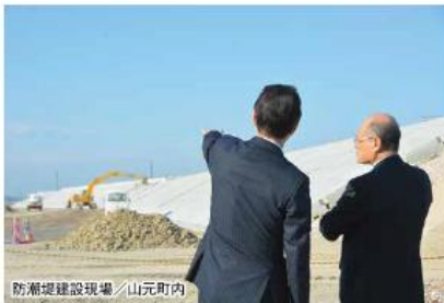
防潮堤建設現場／山元町内
