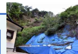
豪雨の度に 土砂崩れが多発
