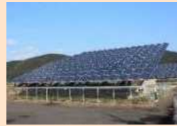
再エネ発電設備 など
