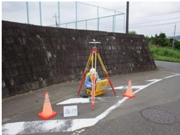
G N S S による調整用基準点の設置
