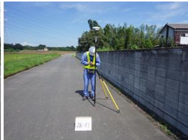
G N S S による調整用基準点の設置
