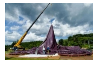
設置中の様子
