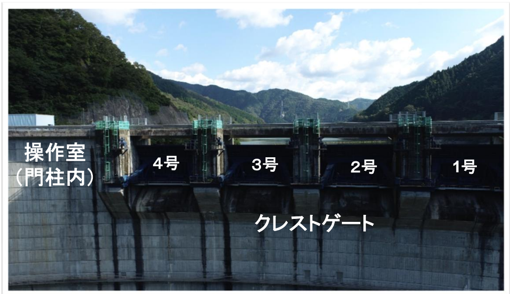
クレストゲート(非常用:鋼製テンターゲート)
