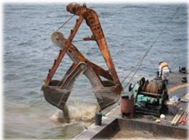
三河湾における矢作ダム堆積砂を利用した干潟・浅場造成試験 (愛知県 HPより)
