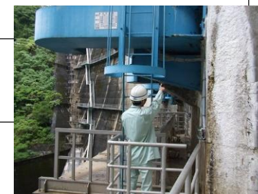
ゲートの点検
