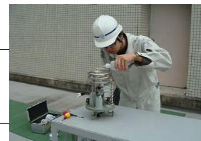
雨量計の点検
