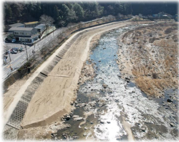
矢作川における 土砂供給実験の状況 (小渡地区)
