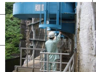
ゲートの点検
