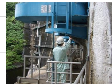
ゲートの点検
