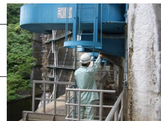
ゲートの点検
