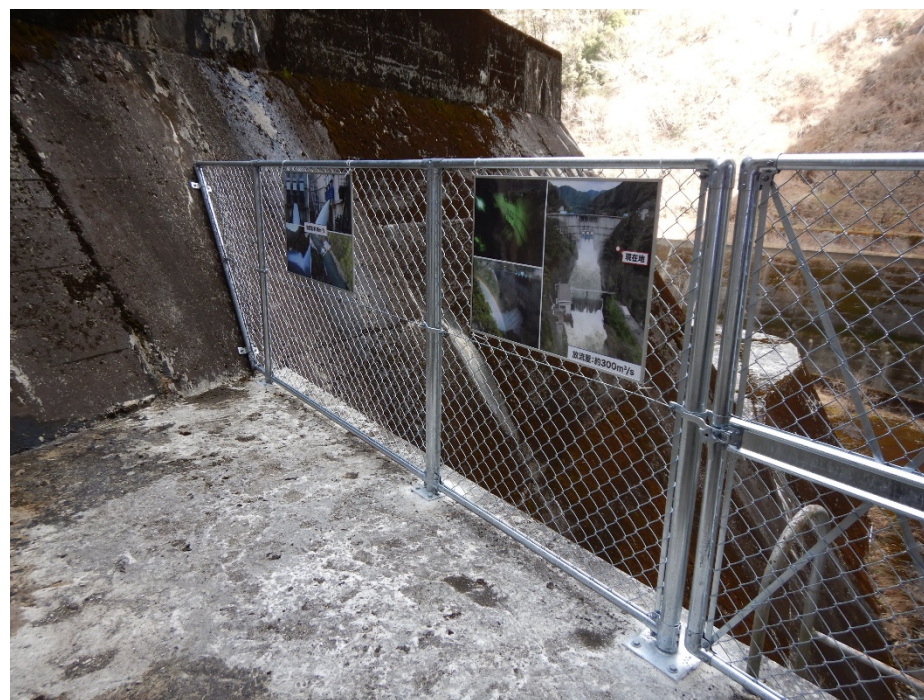
安全柵を設置した見学用バルコニー（新設） （ダム左岸 天端から約60m下）
