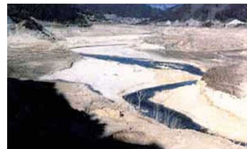
平成6年渇水時における 矢作ダム貯水池の状況
