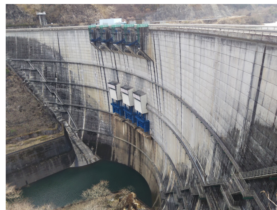
展望台から見るダム全景
