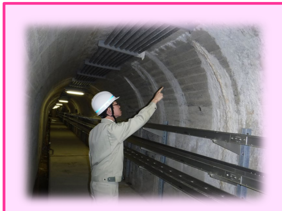
ダム堤体内の点検(イメージ)
