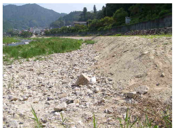
写真-4 法面整形後
