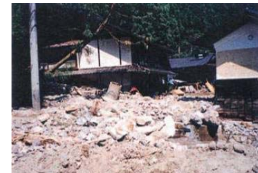
土石流被害の状況 (犬間沢・旧上矢作町達原)
