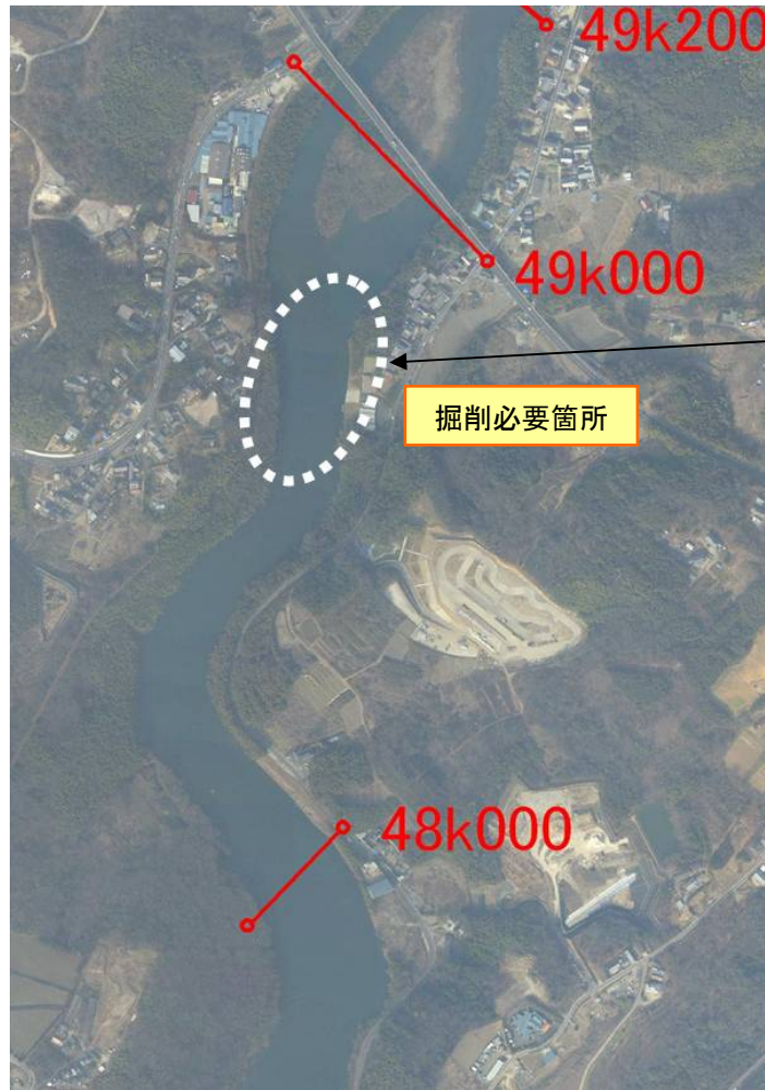
図 掘削必要箇所①(越戸ダム湛水域)
