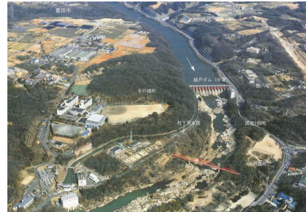
写真 越戸ダム直下流区間の状況
