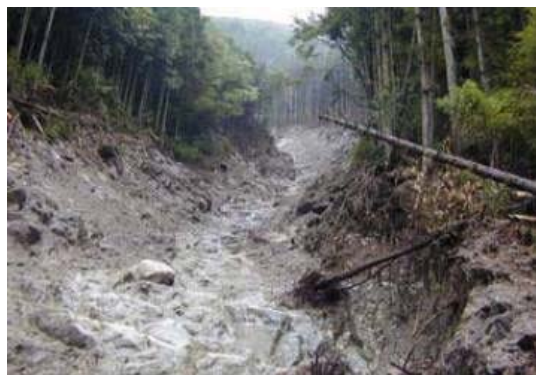
上村川沿川の沢抜け(旧上矢作町)
