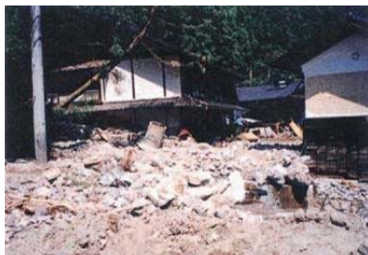
土石流により家屋埋没(犬間沢・旧上矢作町達原)
