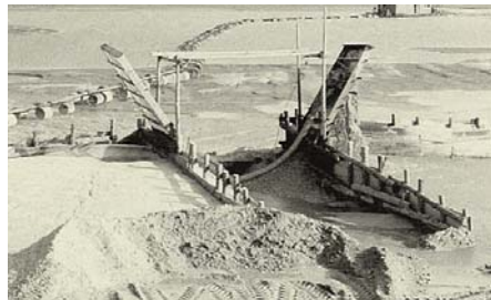
サンドポンプによる砂利採取(S45頃)
