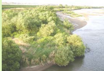
河道内樹木繁茂状況
