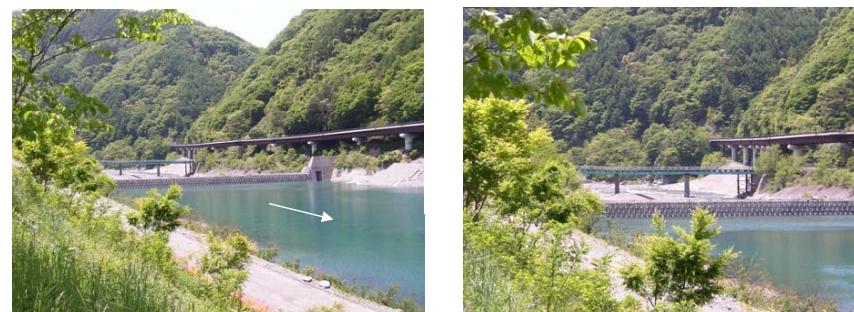
写真 3-1 透過型構造の貯砂ダムの例（美和ダム：下流から）
