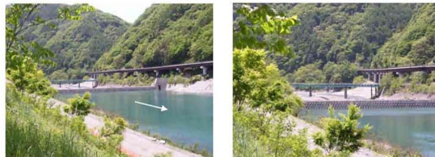
写真 4-1 透過型構造の貯砂ダムの例（美和ダム：下流から）
