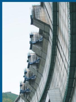
大雨などでダム湖に流れ込む水の量がとても多く、ダムから水があふれてしまいそうな緊急時にだけこの設備から水を流します。矢作ダムでは、現在まで、平成12年の東海(恵南)豪雨の時に初めて使用しました。
