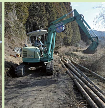
整備した林道で間伐材を運搬しています。
