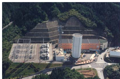
奥矢作第一発電所
