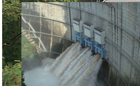
矢作ダムからの放流
