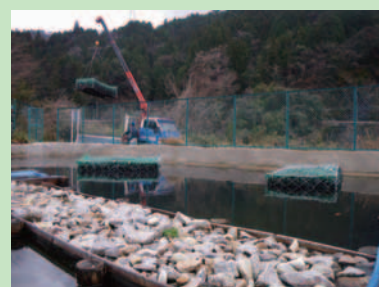
沈砂池へふとん籠に入れた炭を設置
