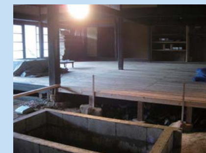
新しく床板のはられた古民家。
