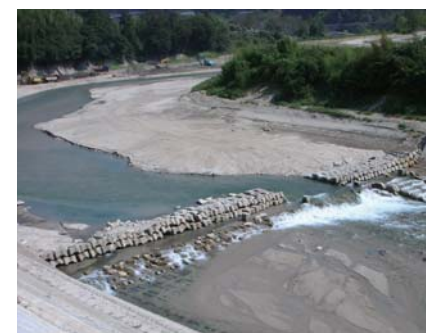
現在の貯砂ダムの状況(ダム湖上流約6km)
