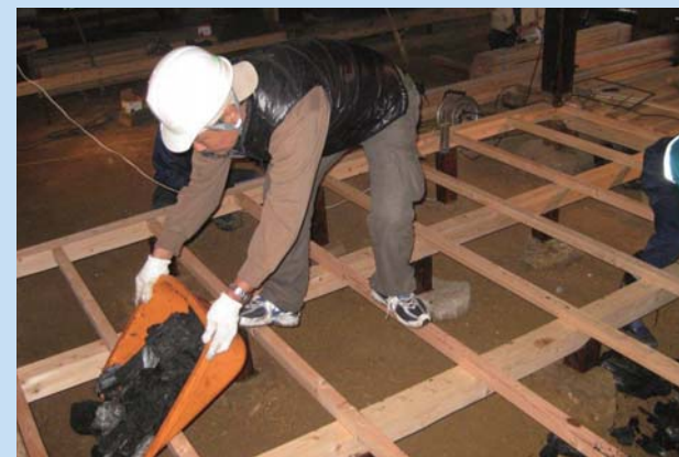
床下には、奥矢作湖・炭やきの里でつくった炭が一面に敷き詰められています。
