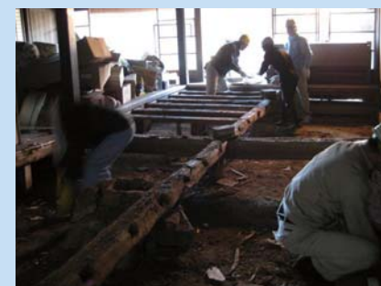
痛んだ床は取り外しました。
