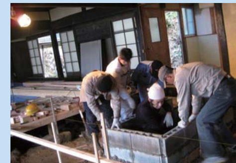
縦約1m、横約2mの「いろり」も塾生の手で再現しました。
