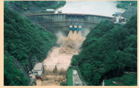
常用洪水吐ゲートからの放流状況
