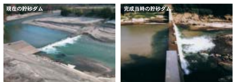
完成当時と比べて、今の貯砂ダム付近はすっかり土砂におおわれています。
