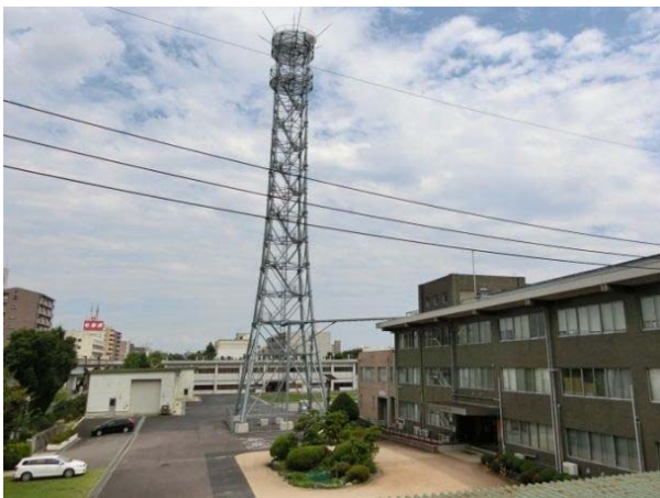
亜鉛メッキを施した鉄塔の例
