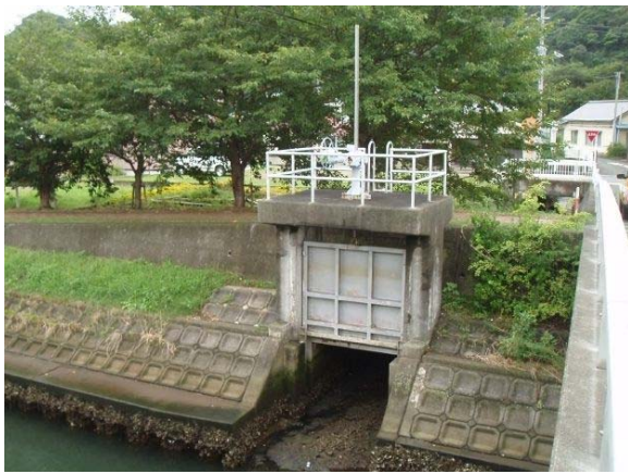
コンクリートと類似する色彩を採用し、周辺景観と調和している事例
