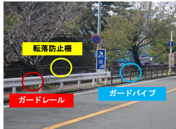
ガードレールとガードパイプが混在している事例
