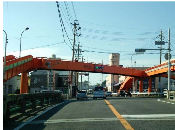
歩道橋の色彩が周辺環境と調和していない事例
