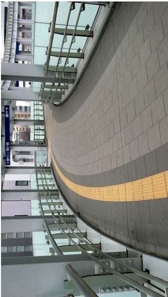
写真 4-9 誘導ブロックの周りを低明度とし、適切な輝度比を確保する
