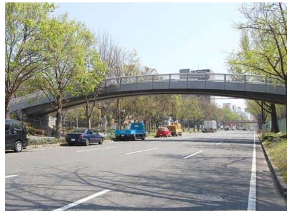
歩道橋の色が周辺環境と調和している事例
