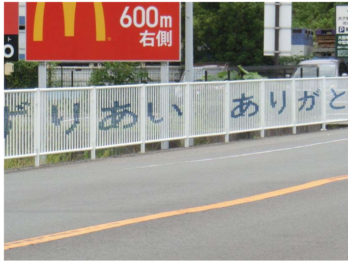
防護柵の装飾の必要性について検討すべき事例
