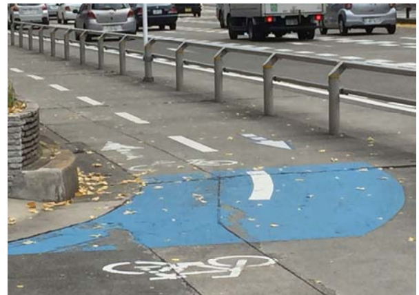
自転車道に彩度が低い青色のカラー舗装を施工し道路空間全体の調和を図った事例
