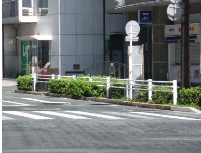
縁石と防護柵を併用している事例
