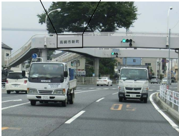
歩道橋の色彩が周辺環境と調和している事例
