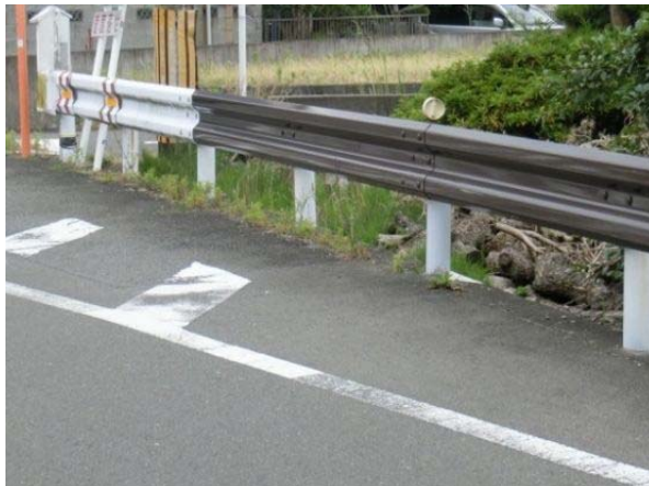
色の異なるガードレールが混在している事例
