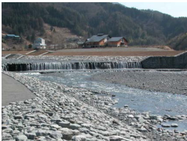
護岸の素材に配慮し周辺景観との調和を図った事例
