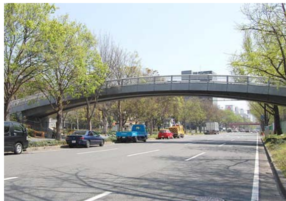
歩道橋の色が周辺環境と調和している事例
