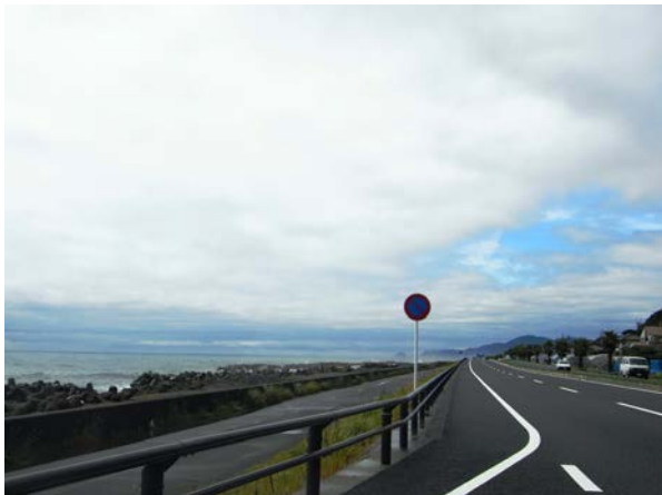
透過性のある構造（ガードパイプ）で施工した事例
