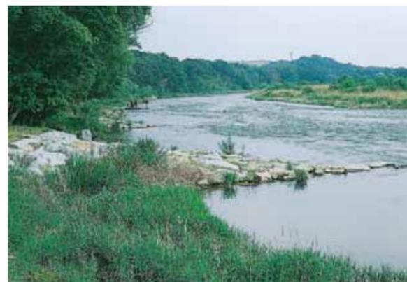
大小の自然石を用いた水制工。川の流れを適度に緩める機能とともに、生態系の保全にも役立っている（矢作川水制工、愛知県 photo 佐藤日出夫）
