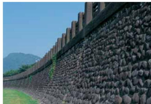
玉石積みみの堤防。堤防上部には量をはさみ込み、かさ上げできるようにした「角落」を備えている（長良川の特設堤、岐阜県岐阜市 photo 佐藤日出夫）
