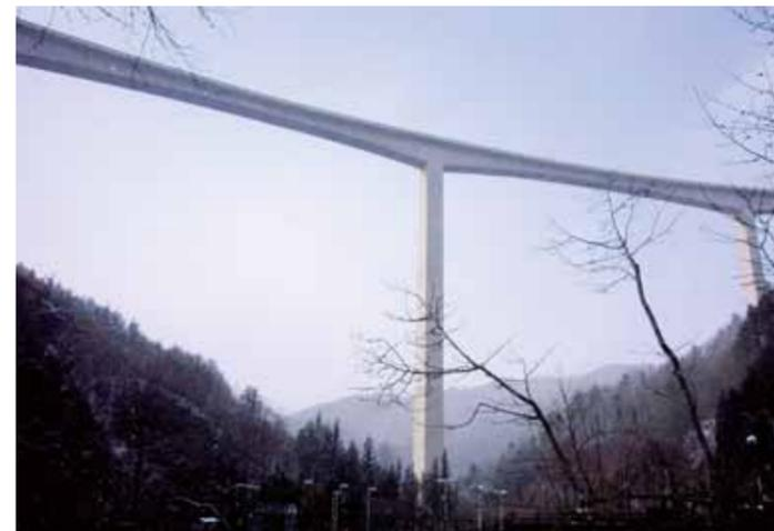
橋脚高日本一（118m）。高強度材料を用いて断面積を抑えたことにより経済性、施工性に優れ、圧迫感の少ないデザインを可能にした（東海北陸自動車道鷺見橋、岐阜県郡上市 photo 林英光）
