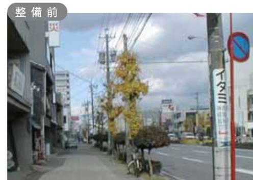
電線共同溝の整備により、電線、電柱のない、より良い景観づくりを進める (国道23号津市岩田電線共同溝)
