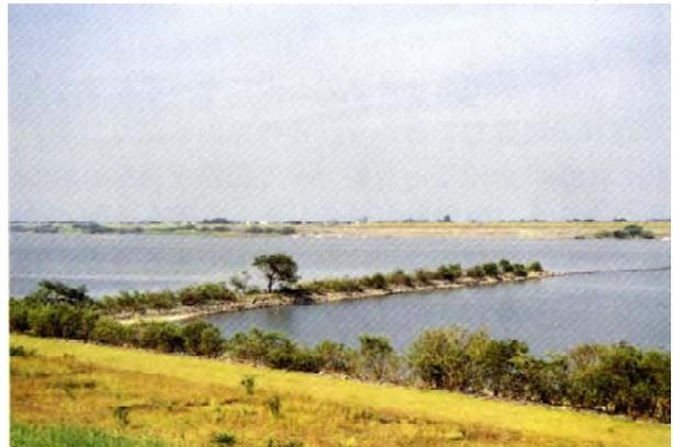
写真 26. 日本の伝統的な工法は、生態系への配慮にも優れたものが多い（木曾川のケレップ水制）
