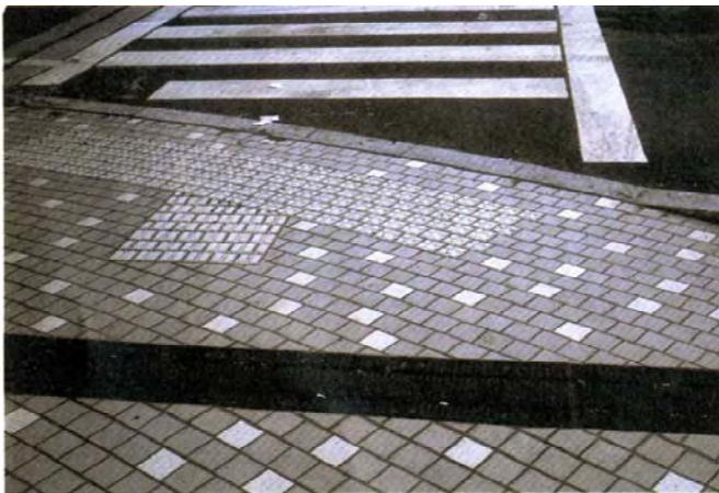
写真 23. 点字ブロックをグレーにするよりも、舗装パターン、伸縮目地などの収まりの仕上げをもっと丁寧にすべきであろう
