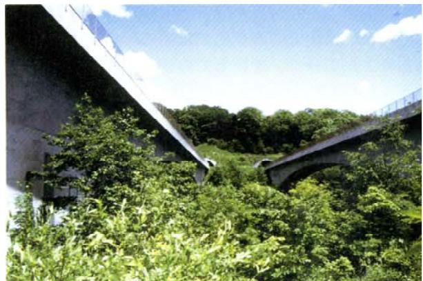
写真 27. 湿原を保存するため道路線形、橋梁の基本構造から工夫した結果、造形的にも優れたものとなった（北海道、ポロト橋）
