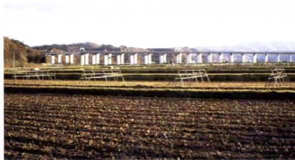
写真7. 広々とした田園風景に融和させるためには、もう少し路面位置を下げて、橋脚を細く見せる工夫が欲しい
