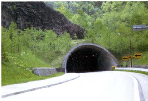
写真 17. トンネル坑口と地山との境を植栽で上手く修景している（北海道）
