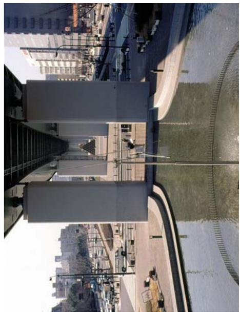
写真 S-1 塗装されたコンクリートは表面の肌理が細かいため、素材のままよりも艶のある色彩に感じられる
