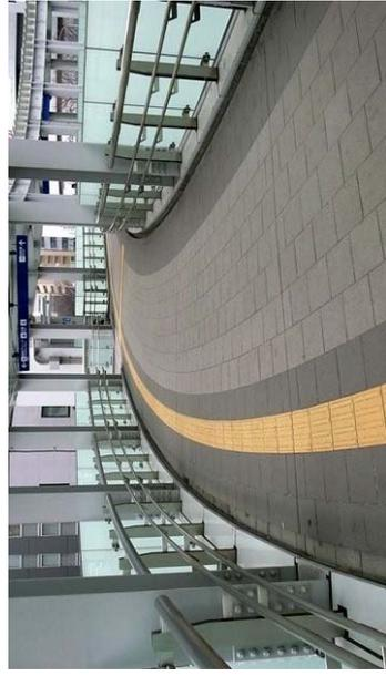
写真 4-9 誘導ブロックの周りを低明度とし、適切な輝度比を確保すること。
