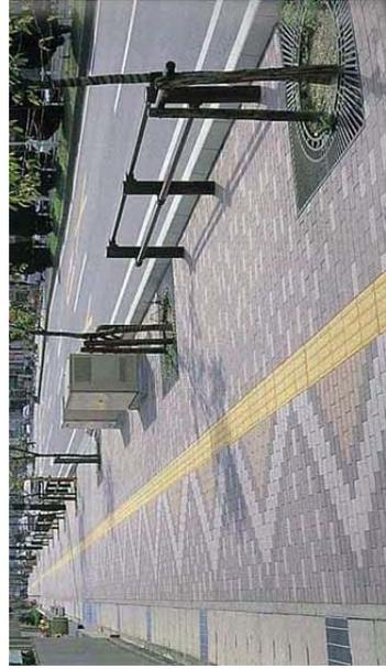
写真 S-12 透水性舗装による歩道舗装
