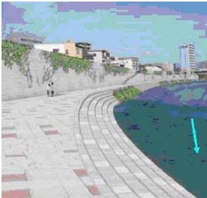
堤体の緑化と、低水護岸への植生の導入イメージ
