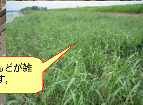
ヨシ根混入土状況写真
