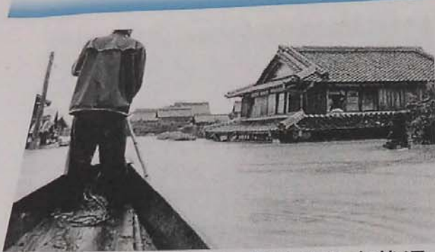
昭和37年7月洪水における浸水状況 (豊川市当古町)
