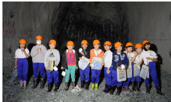
豊川用水工事現場見学(発表資料抜粋)
