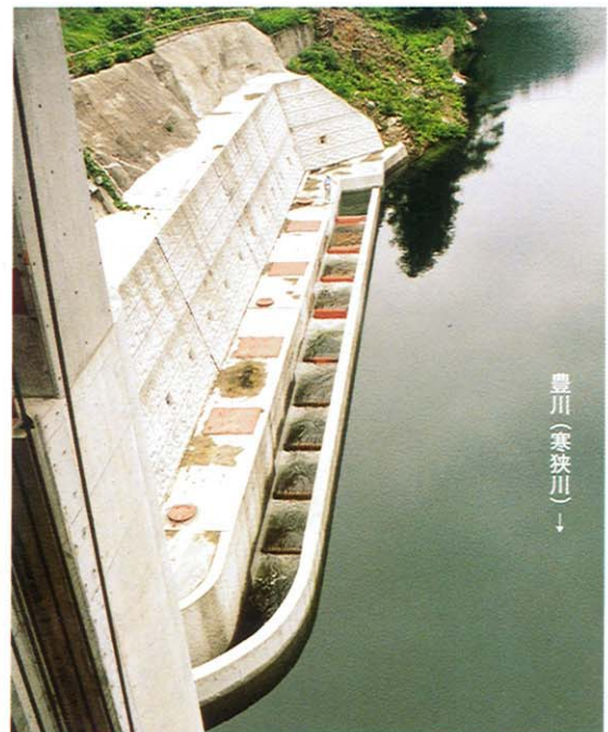
寒狭川頭首工 階段式魚道
