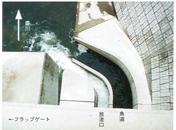
←フラップゲート 放流口 魚道 寒狭川頭首工下流
