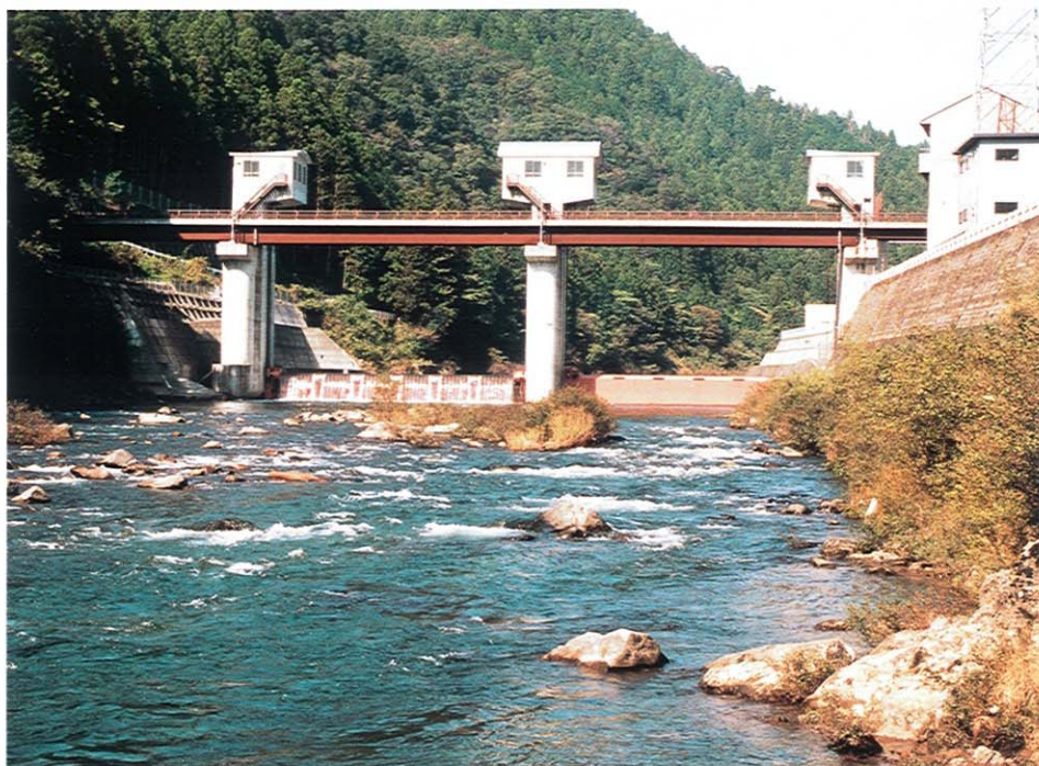
寒狭川頭首工
