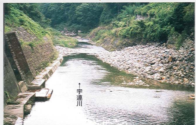
流況改善後 [1.3m 3 /秒放流] (平成9年10月撮影)
