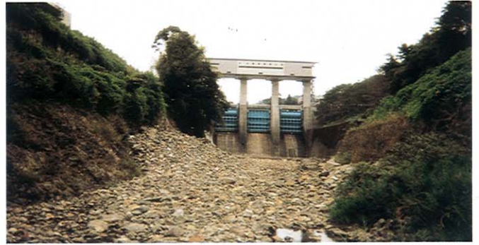
川底が露出する大野頭首工下流
