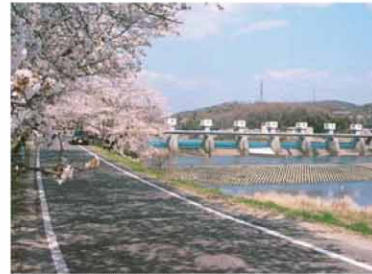
明治用水頭首工
