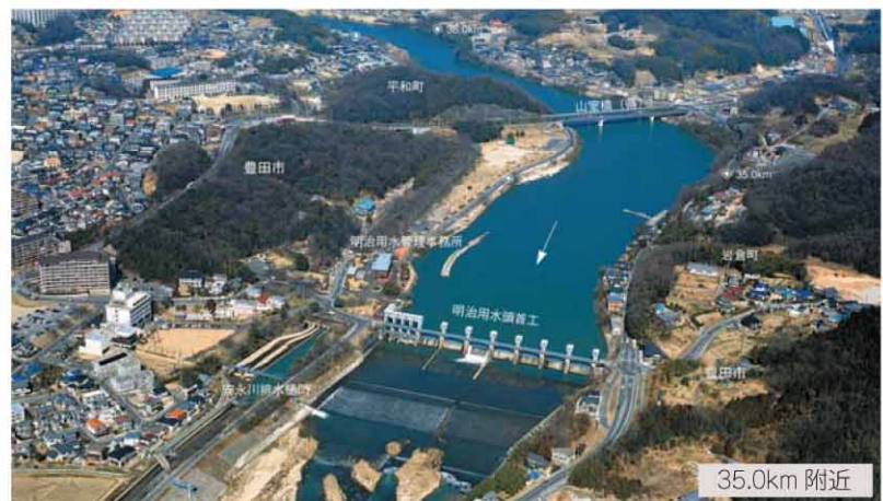
明治頭首工周辺
