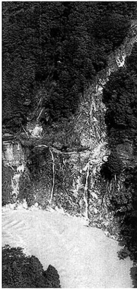
大規模な土砂崩れによって寸断された国道418号（写真中央付近）＝上矢作町遠原で
