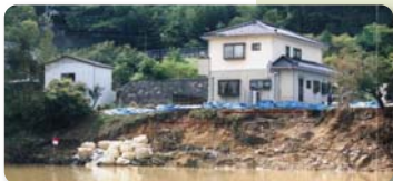
斜面崩壊の状況（豊田市平和町）
