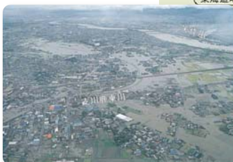
支川鹿乗川の内水被害状況（岡崎市）
