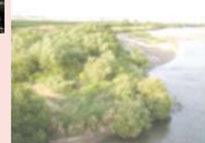
河道内樹木繁茂状況
