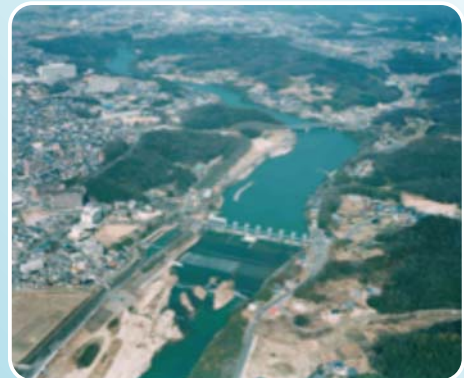
明治用水頭首工と鶴の首狭窄部
