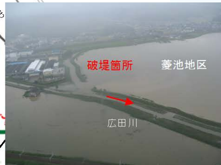
広田川流域の浸水状況(H20.8.29) (破堤箇所 赤川合流点10k900 付近)
