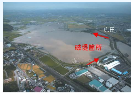
広田川流域の浸水状況(H20.8.29) (破堤箇所 赤川合流点10k900 付近)
