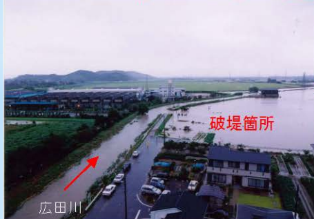
広田川流域の浸水状況(H12.9.11~12) (破堤箇所 11k200 右岸付近)
