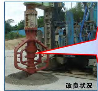
この部分を回転させ地盤内に貫入させ、固材と地盤の土を攪拌し、強固な支持地盤を形成します。
