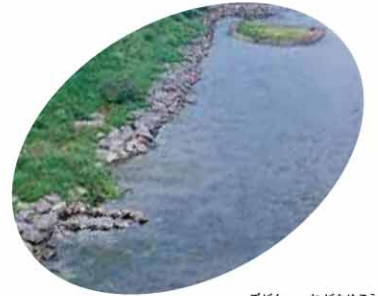
自然石を使っている向河原護岸の根固工(豊川市)
