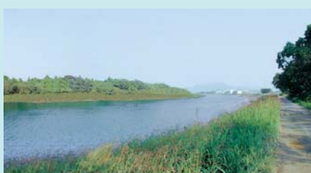
改修後（モニタージュ写真）
