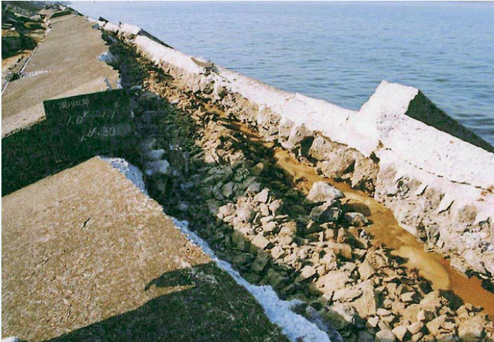
兵庫県南部地震で液状化現象により壊れた淀川の堤防 (提供:近畿地方整備局淀川河川事務所)
