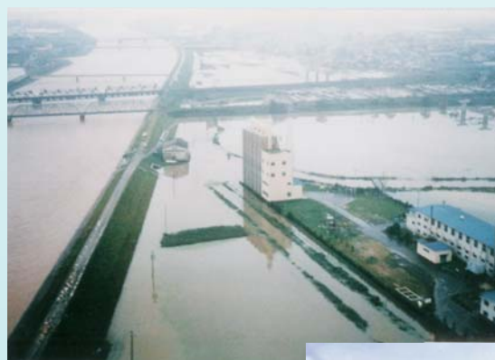
昭和57年8月洪水 小坂井排水機場 付近の浸水状況
