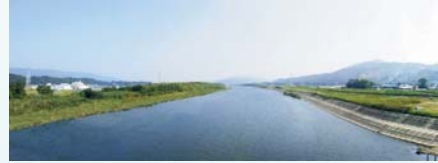
改修後（モニタージュ写真）
