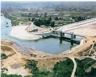
放水路建設時の状況
