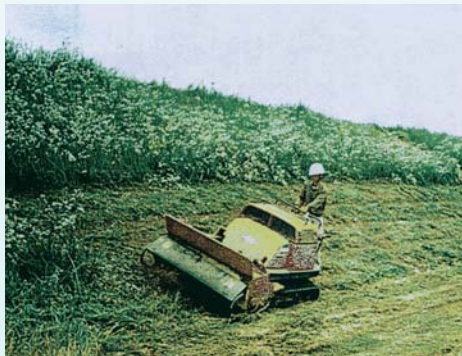
堤防除草作業状況
