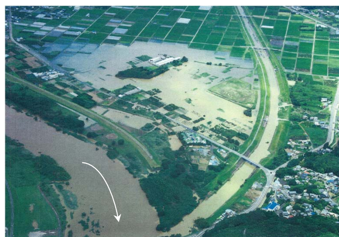
平成19年7月 台風4号 豊橋市賀茂町／豊川市三上町（賀茂霞）
