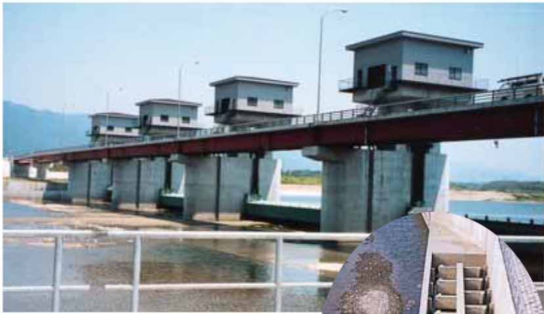
牟呂松原頭首工
