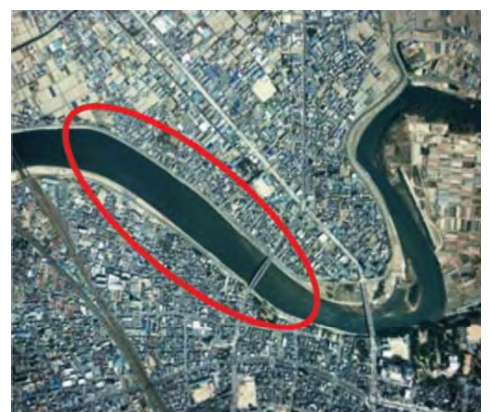
吉田大橋下流市街地区 上段：施工前(昭和30年代) 下段：施工後(平成8年)
