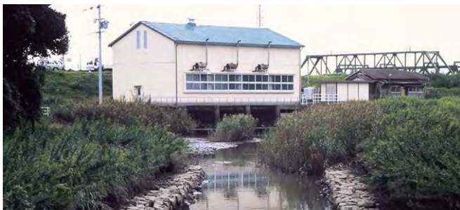
昭和40年度に完成した小坂井排水機場
