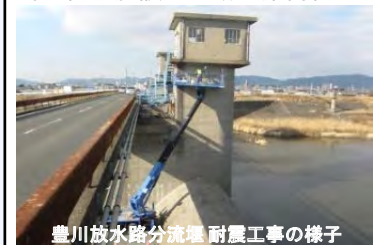
豊川放水路分流堤耐震工事の様子
