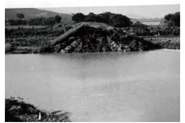
昭和44年8月(台風7号)江島堤防決壊箇所
