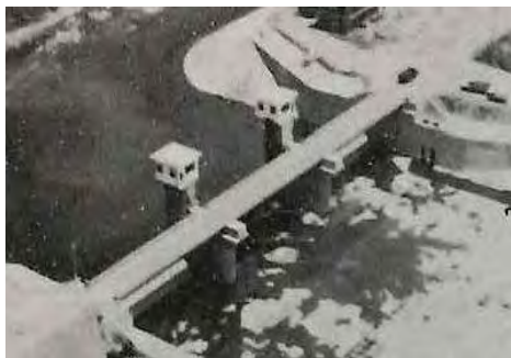
豊川放水路 竣工
