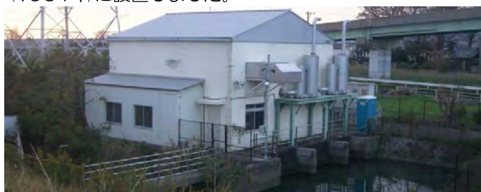
昭和39年度に完成した平井排水機場
