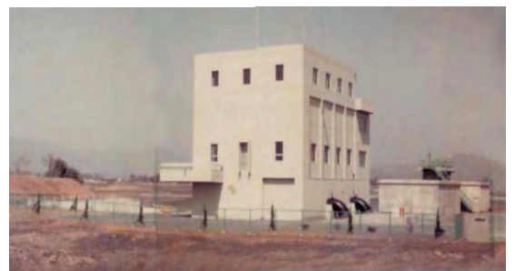
古川排水機場
