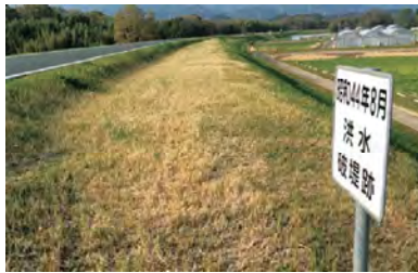
現在の破堤箇所の状況
