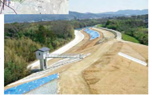
築堤施工状況
