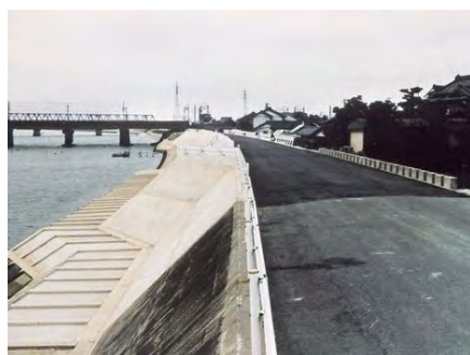
昭和62年 完成した豊川狭さく部特殊堤
