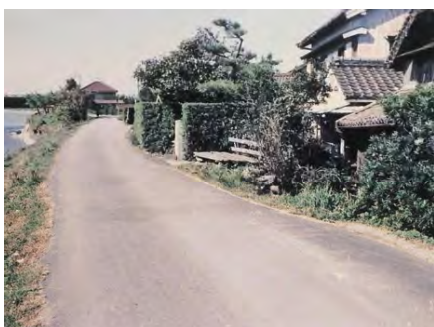
昭和48年 豊橋市下地町改修前の豊川右岸狭さく部 下流に見える橋はJR鉄橋
