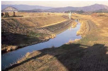
間川の改修概成下流部より上流を望む
