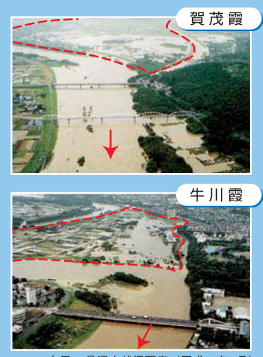
台風10号浸水状況写真 (平成15年8月)
