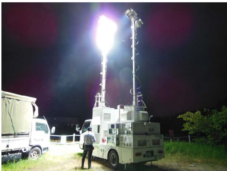
男川浄水場における照明車による支援状況
