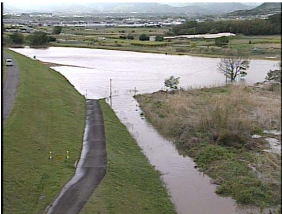
賀茂霞浸水状況(②)
